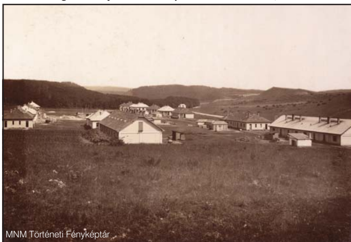
A gánti bányászkolónia épületei délkelet felől, 1928
