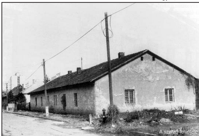
19. századi munkásbarakkból kialakított lakóház. Diósgyőr, 1996
