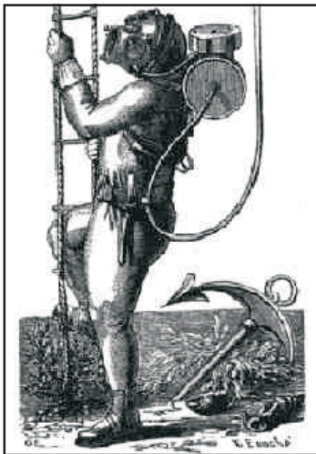
Rouquayrol és Denayrouze bűvárruhája és felszerelése, 1873
